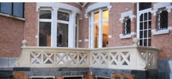
Une balustrade à Bruxelles qui retrouve sa jeunesse.
