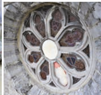
Une rosace en béton avant et après son travail.
